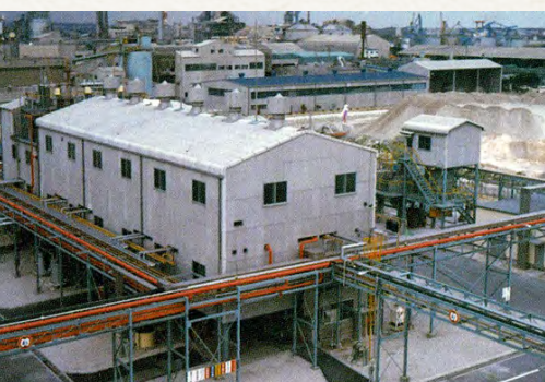
有機フッ化物の多目的製造設備
