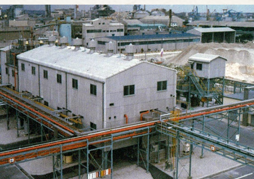
有機フッ化物の多目的製造設備
