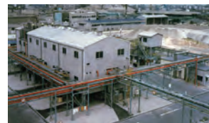
有機フッ化物の多目的製造設備(1984年)
