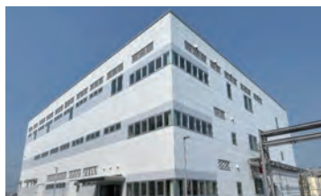
機能材料研究棟
