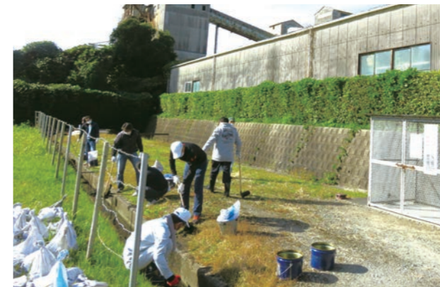
築港地区側溝清掃
