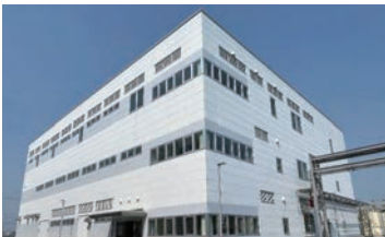
機能材料研究棟
