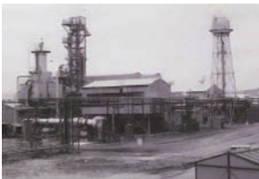
セントラルグラスファイバー株式会社 (現同社松阪工場、1973年)
