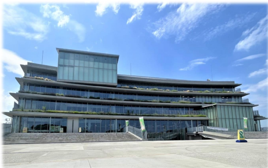
鹿島建設(株) 2022年度竣工 志木市新庁舎
