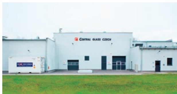
セントラルガラスチェコs.r.o.外観
