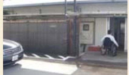
段差をなくしたバリアフリー化の一例（松阪工場）
