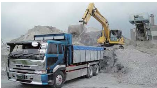
汚泥積み込み(宇部工場)
